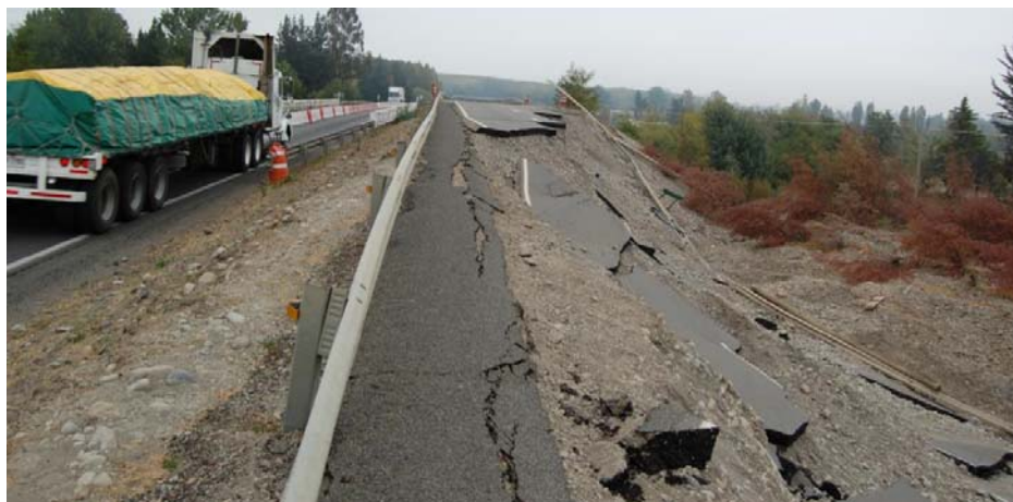
Fig. 4.- Failure of Paso Superior Copihue
