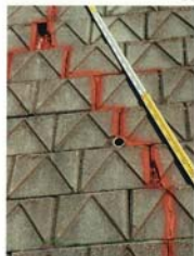
ブロック積擁壁に発生した縦キレツ(剥離跡あり)
