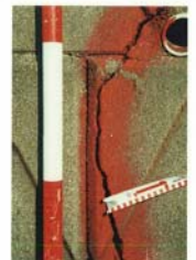
ブロック積擁壁に発生した縦キレツ(開口7.5mm)
