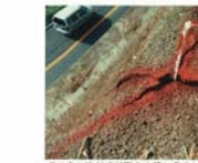
モルタル収付のり面の小段に発生したキレツ(地山との間に空溜が認められる)
