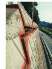
ブロック積擁壁に発生した水平キレツ
