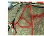
モルタル収付のり面に発生した開口キレツ
