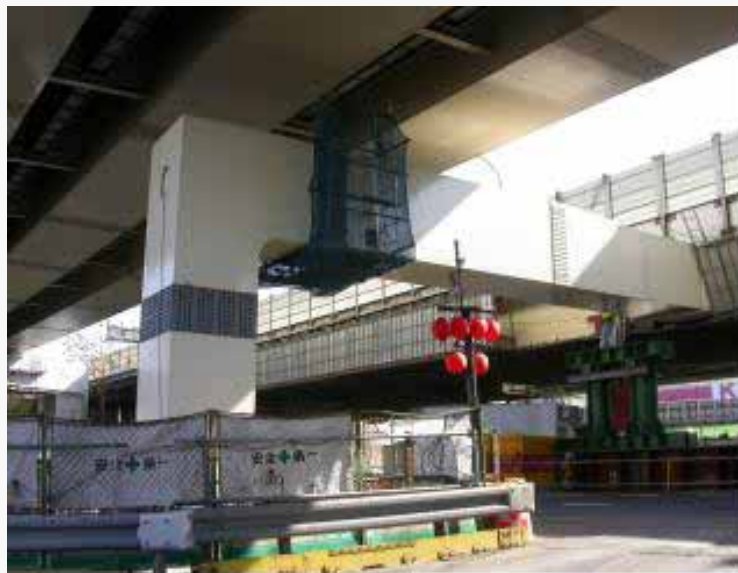
架設された立体ラーメン橋の柱と梁
