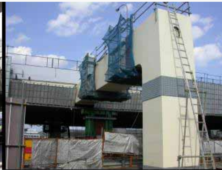
架設された立体ラーメン橋の柱と梁
