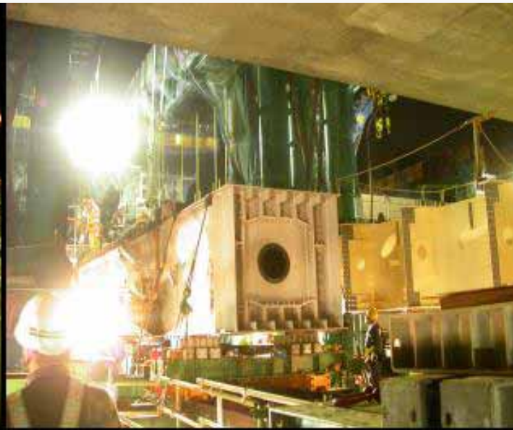
横梁取替え工事の吊桁(左)と搬出される旧横梁(右)
