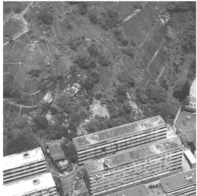
Fig. 19 1999 Shek Kip Mei landslide
