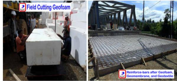
Gambar 13. Aplikasi geofoam di lapangan (Cahyana Styrofoam PT. Cahyana Ekspansindo)
