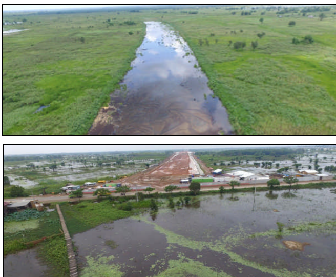
Figure 3 Kondisi Lapangan Proyek Tol Palembang Indralaya
