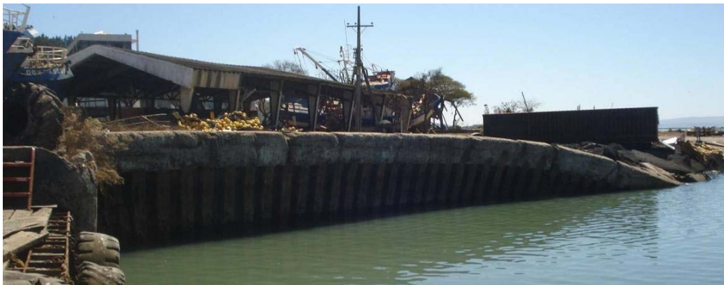
Fig. 18.- Quay wall in La Poza, Talcahuano
